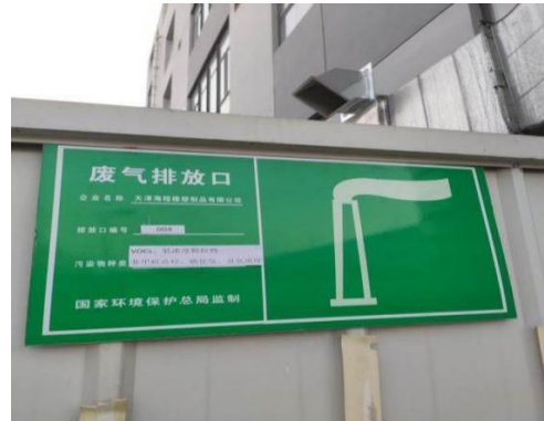
P4 排气筒标识牌
