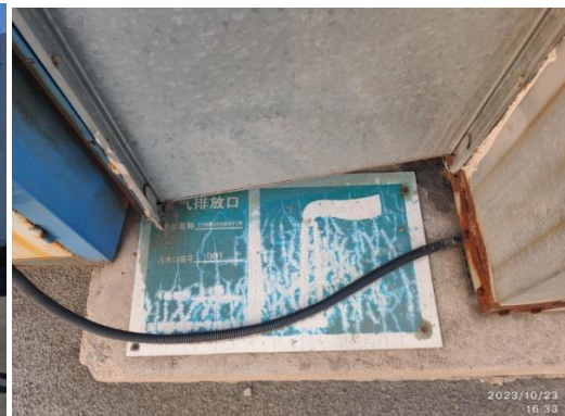
P2 排气口标识牌
