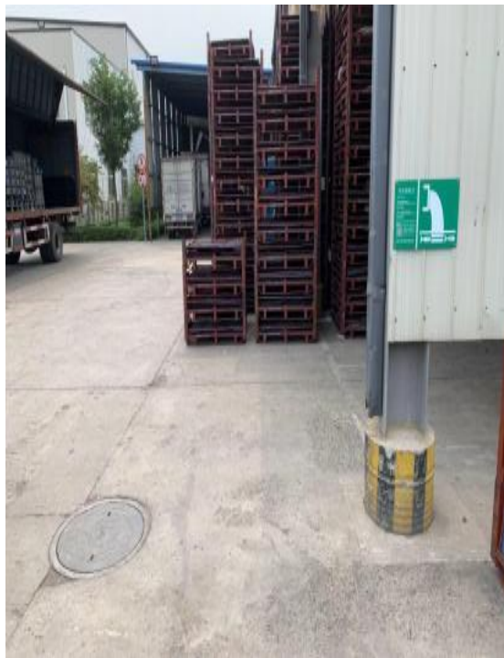
一厂污水总排口规范化
