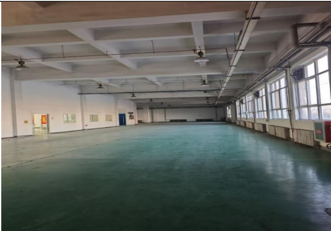
图 2-6 本项目厂房现状照片
